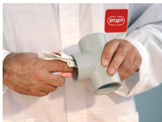
**Lasciare asciugare le superfici qualche minuto prima di applicare il collante.** Si ricorda che l'impiego dei Detergenti Primer TemperFIP100® o Primer P70, oltre a detergere e pulire le superfici da giuntare, svolge anche un'importante azione di rammollimento e predisposizione alla ricezione del collante, operazione che permette di ottenere una giunzione ottimale.
